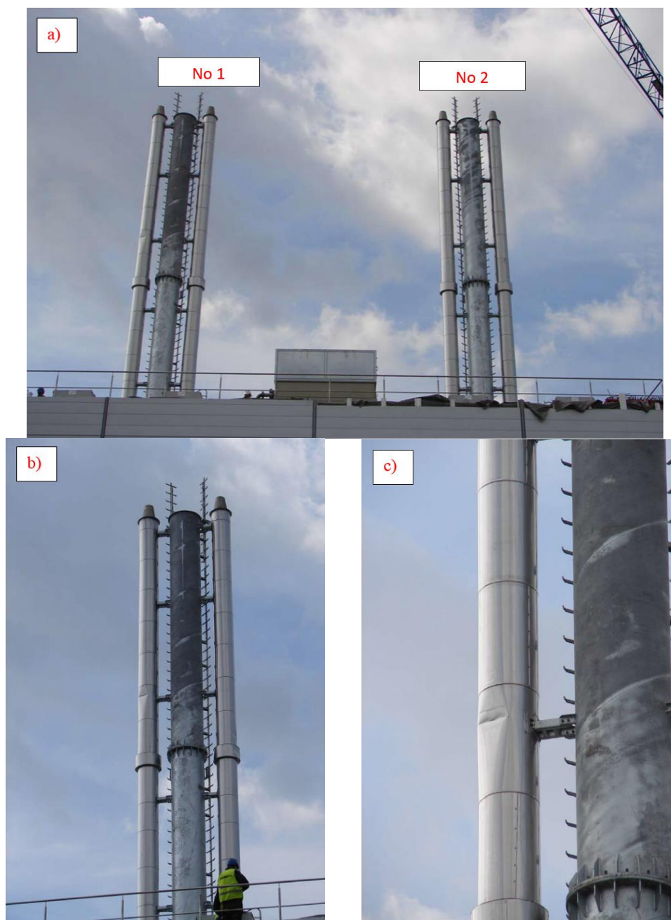
Rys. 1 a-c. Widok konstrukcji trzonu nośnego komina z rurami spalinowymi.
