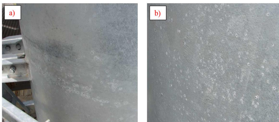
Rys. 7. Efekt tzw. „białej rdzy” na powierzchni powłoki cynkowej.
