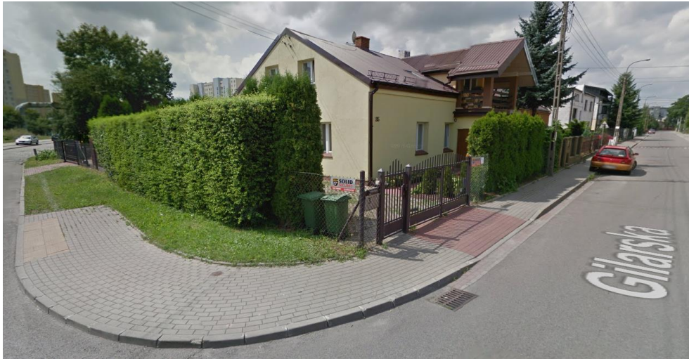
Rys. 2. Widok badanego obiektu budowlanego.
