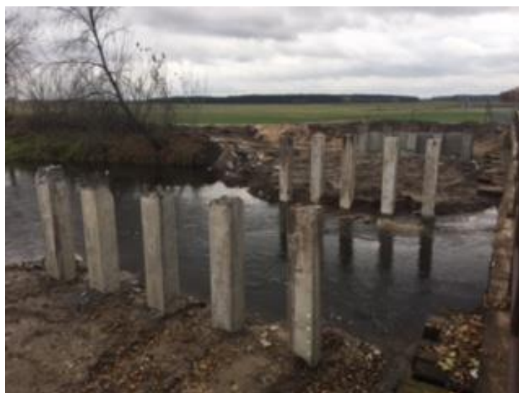
Rys. 12. Etap budowy podpór palowych pośrednich [6].
