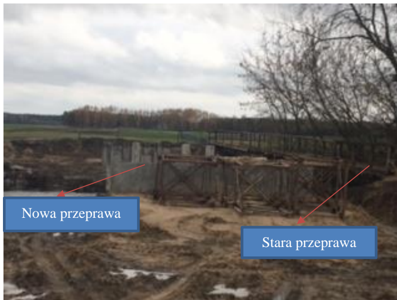
Rys. 11. Usytuowanie osi nowego mostu względem starej przeprawy [6].
