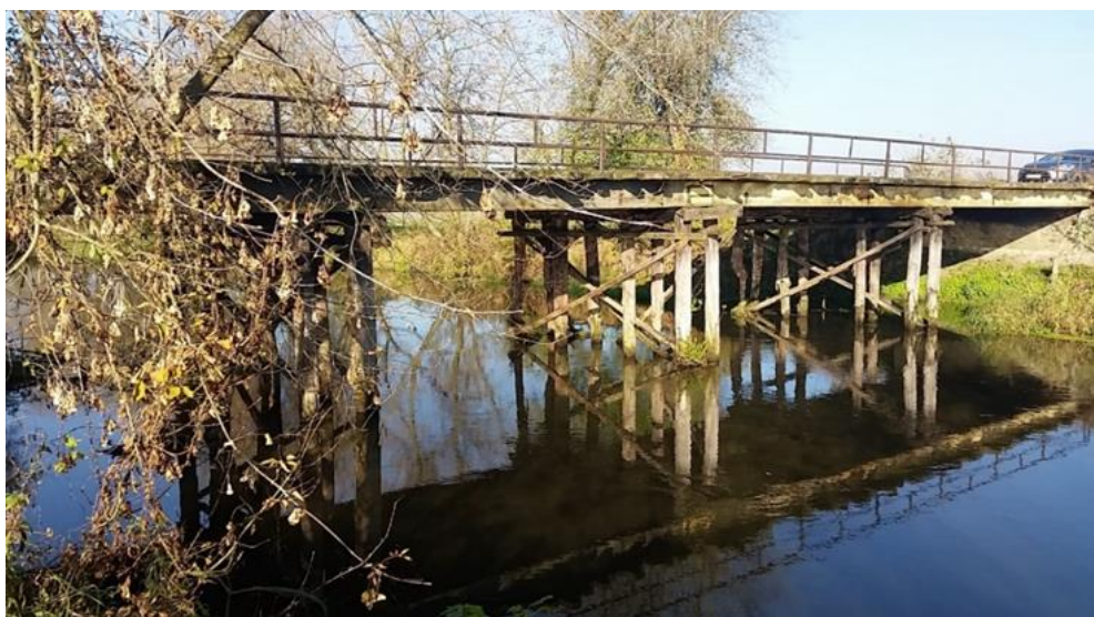
Rys. 1. Widok przeprawy na rzece Bzura w m. Klewków przed modernizacją (opracowanie własne).
