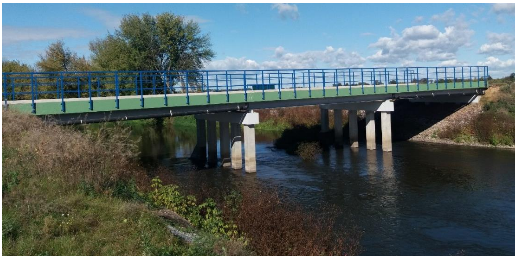
Rys. 10. Widok na nową konstrukcję mostu (zdjęcie własne).
