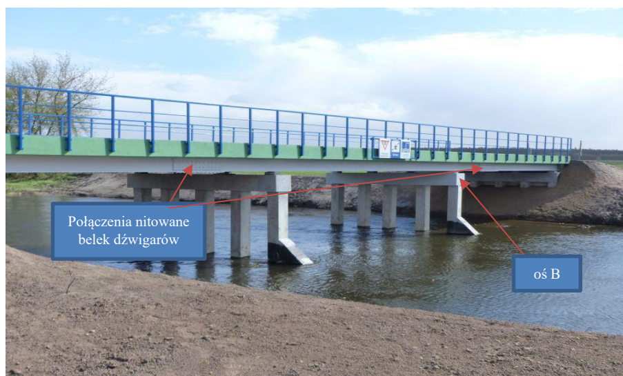
Rys. 14. Widok na całą konstrukcję mostu z widocznymi połączeniami belek w dźwigarze [7].
