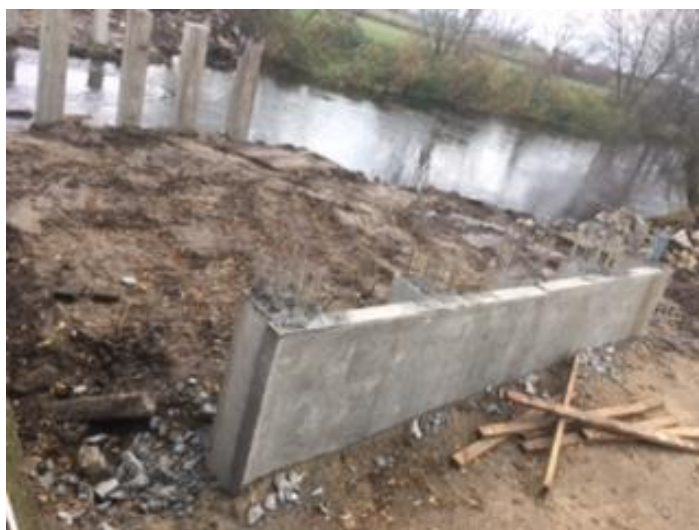
Rys. 13. Widok na podporę brzegową ze ścianką oporową [6].
