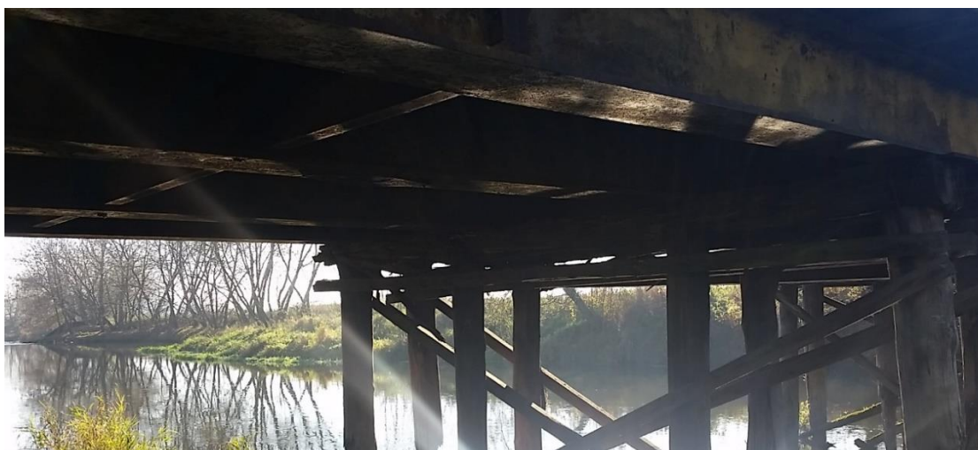
Rys. 2. Widok na stalową konstrukcję pomostu (opracowanie własne).
