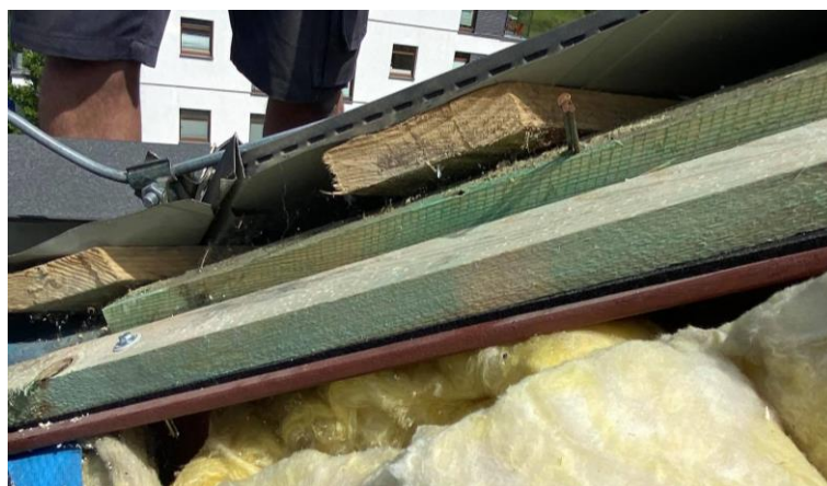
Rys. 4. Zastosowanie łąt drewnianych zamiast deskowania niepełnego [7].
