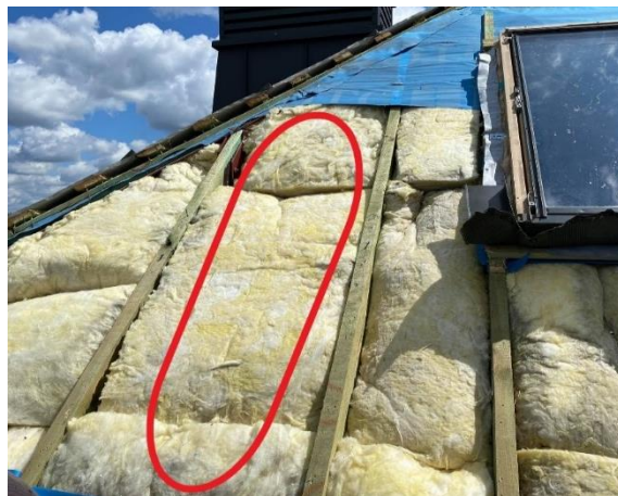
Rys. 3d. Wełna mineralna (obwiedziona kolorem czerwonym) [7].
