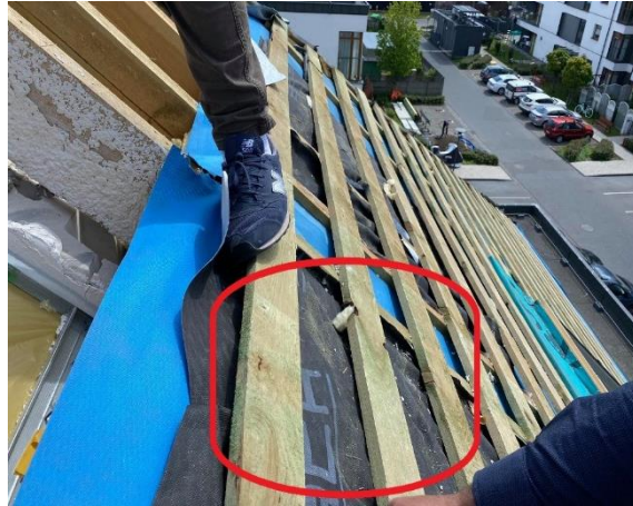
Rys. 3b. Łaty drewniane pod panel dachowy z blachy stalowej powlekanej (oznaczone kolorem czerwonym) [7].
