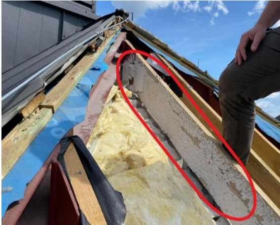
Rys. 3e. Drewniana krokiew dachowa (obwiedziona kolorem czerwonym) [7].
