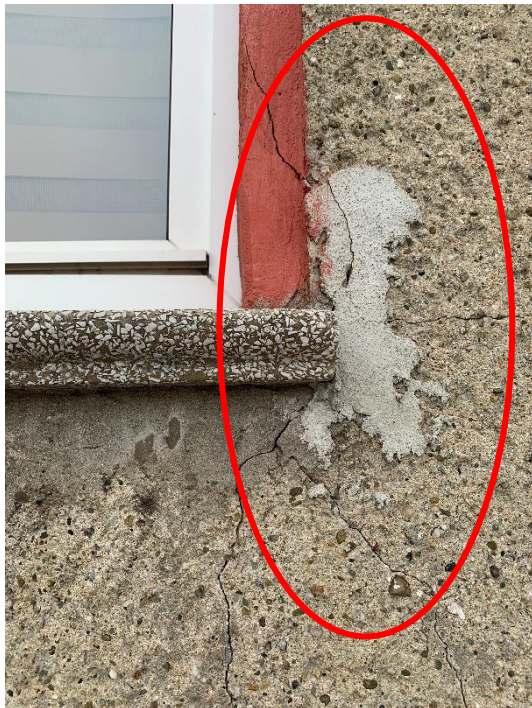
Fot. 4. Widoczne pęknięcia tynku elewacyjnego w okolicach osłabienia ściany otworami okiennymi.
