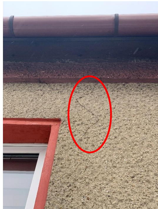
Fot. 4. Widoczne pęknięcia tynku elewacyjnego w okolicach osłabienia ściany otworami okiennymi.
