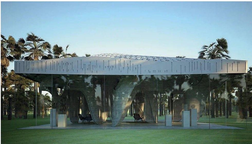
Rys. 8. Obiekt zrealizowany przez drukarkę XtreeE [Walasek M., 3d.edu.pl, 2021].
