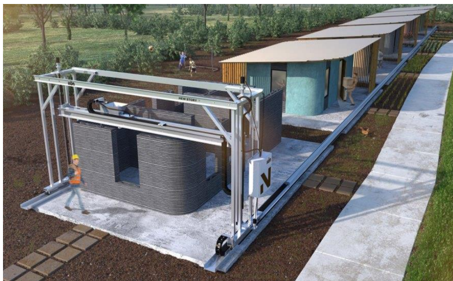
Rys. 2. Drukarka 3D Vulcan (11,5 stopy wysokości, 33 stopy szerokości) [Walasek M., 3d.edu.pl, 2021].
