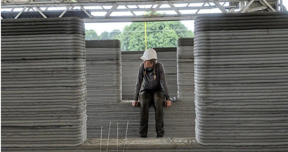
Rys. 7. Budowa osiedla w Meksyku złożonego z 50 domów realizowana przez drukarkę Vulcan firmy Icon [Walasek M., 3d.edu.pl, 2021].
