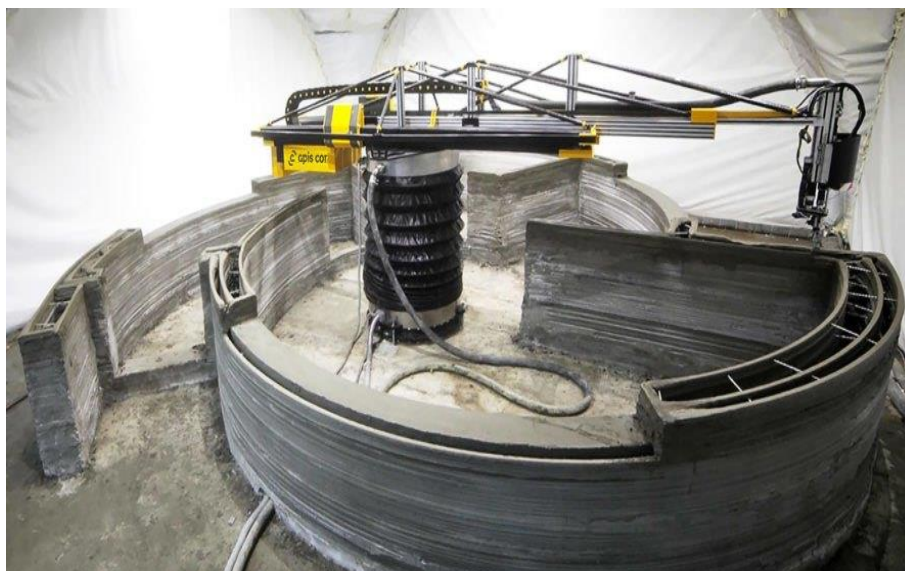
Rys. 1. Drukarka 3D Apis Cor (8,5 m x 1,6 m x 1,5 m) [Walasek M., 3d.edu.pl, 2021].
