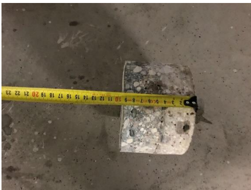
Rys. 2.3. Pomiar grubości odwiertu wykonanego w posadzce garażu podziemnego – wynik pomiaru 9,5 cm.
