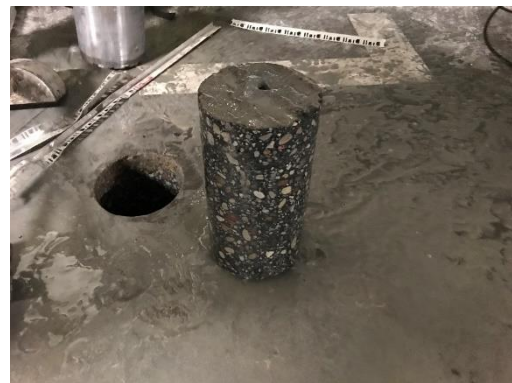
Rys. 2.4. Widok ogólny odwiertu wykonanego w płycie fundamentowej garażu podziemnego.
