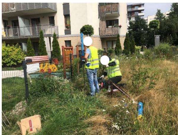
Rys. 4. Widok ogólny badania stopnia zagęszczenia gruntu sondą dynamiczną DPL.
