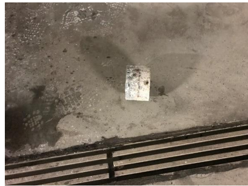
Rys. 2.2. Widok ogólny odwiertu wykonanego w posadzce garażu podziemnego.
