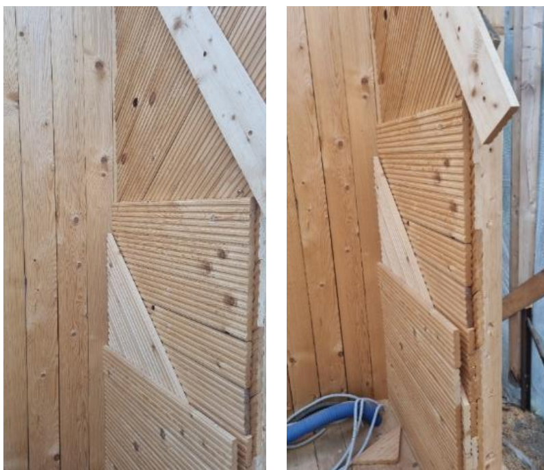
Rys. 23, 24. Sposób ułożenia warstw ściany zewnętrznej (zdjęcia własne).
