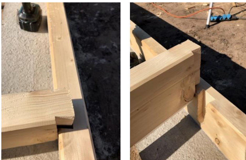
Rys. 10, 11. Połączenie na jaskółczy ogon w płycie (zdjęcia własne).
