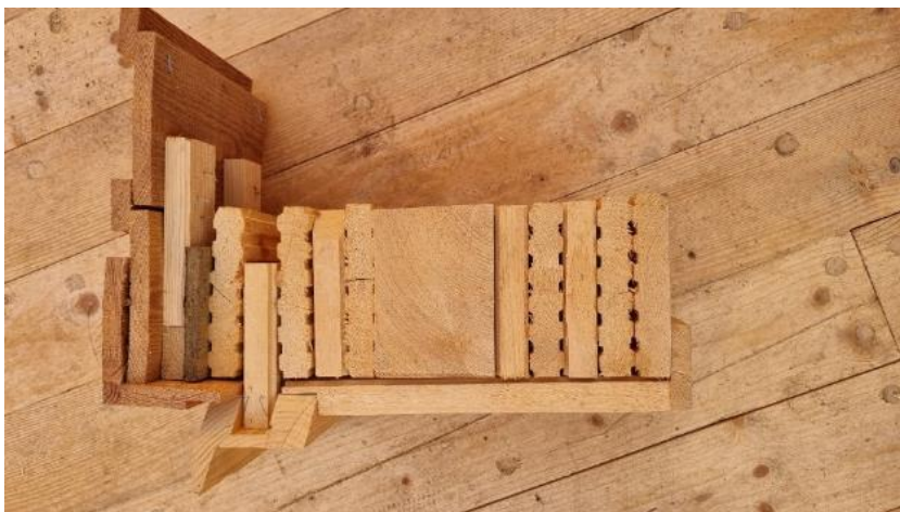
Rys. 21. Przekrój ściany zewnętrznej (zdjęcia własne).
