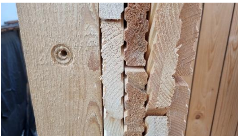
Rys. 22. Bieżące zaawansowanie warstw ściany zewnętrznej (zdjęcia własne).
