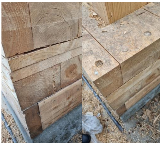
Rys. 18, 19. Płyta fundamentowa i drewniana płyta nośna (zdjęcia własne).
