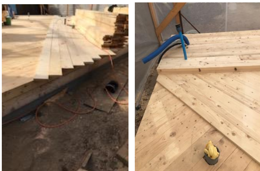
Rys. 16, 17. Ułożenie warstw płyty drewnianej (zdjęcia własne).
