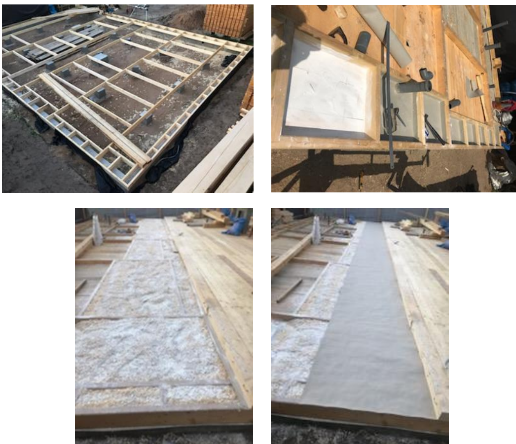
Rys. 12, 13, 14, 15. Wypełnienie płyty trocinami, przykrycie papierem oraz ułożenie litych desek (zdjęcia własne).
