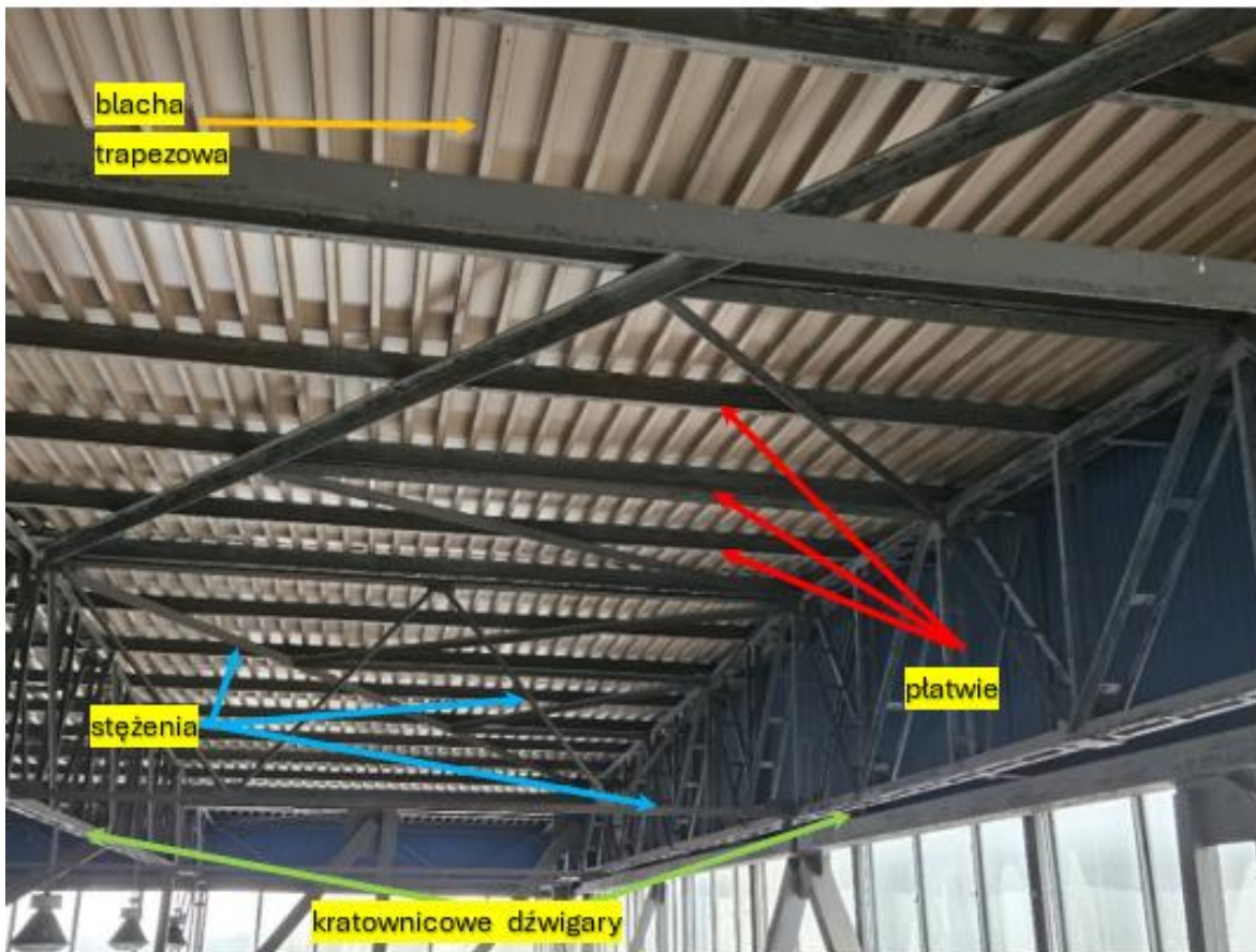
Rys. 1. Konstrukcja dachu hangaru.
